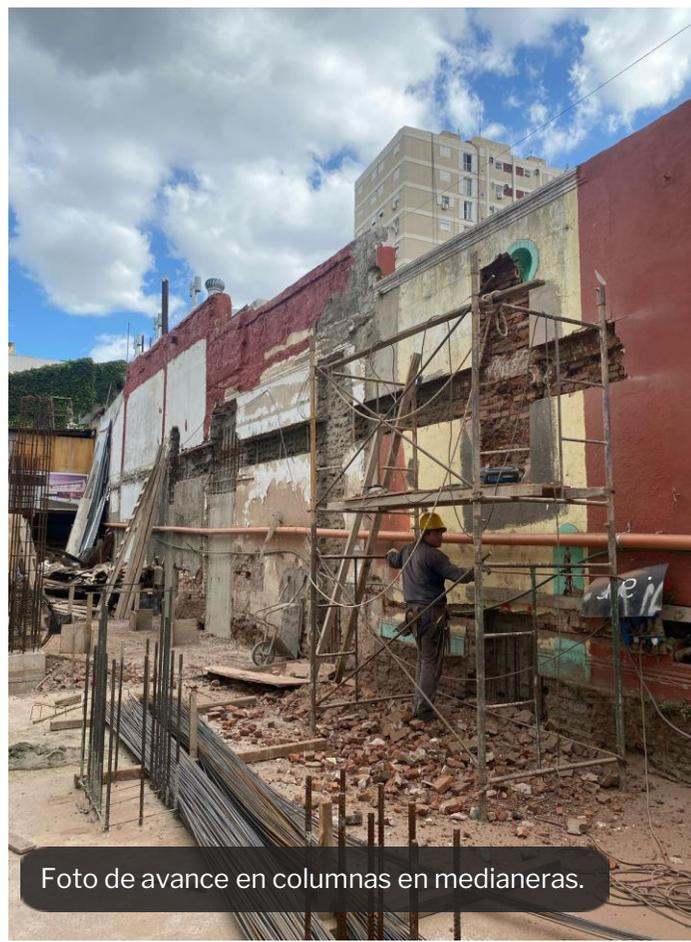
Foto de avance en columnas en medianeras.
