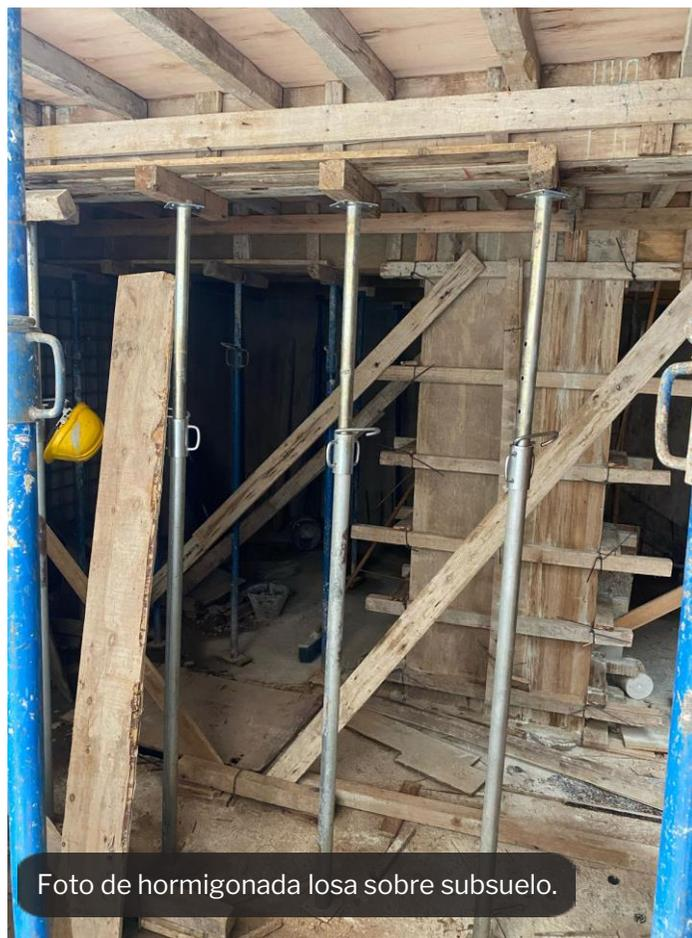
Foto de hormigonada losa sobre subsuelo.
