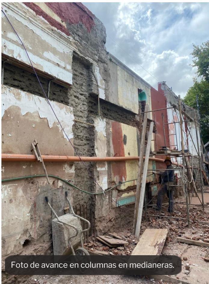
Foto de avance en columnas en medianeras.
