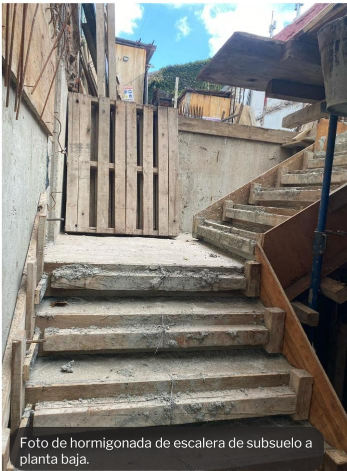
Foto de hormigonada de escalera de subsuelo a planta baja.
